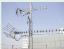
写真2: 一般家庭用UHFテレビ受信アンテナ(上部)と、共同受信設備仕様のアンテナ(下部)を設置した様子
