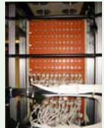
写真3: ベークライト板に中継用F型J-Jを取り付けた中継端子盤
